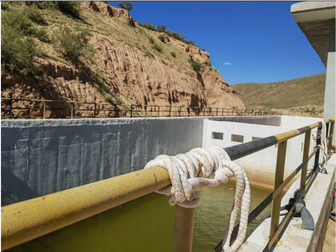
本项目新建调节池
